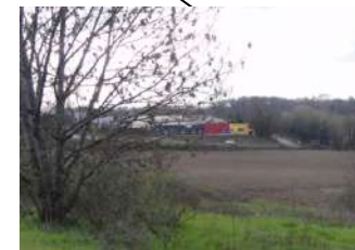
Des façades colorées et un traitement routier
