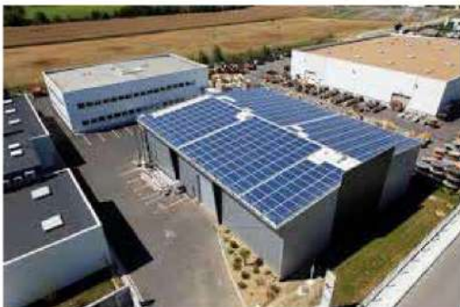
Panneaux photovoltaïques sur toiture inclinée - A PRIVILÉGIER
