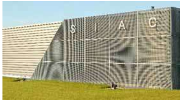
Atelier de câblage à Andrezé (49)
