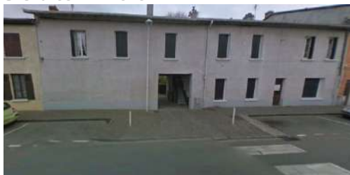
© Google map : vue d'un porche permettant l'accès aux parcelles à l'arrière du front de rue
