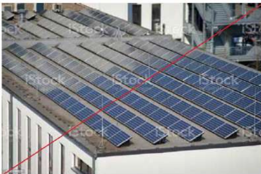
Panneaux photovoltaïques sur toiture plate - A ÉVITER
