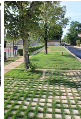
Parking réaménagé avec un système d'infiltration au sol
