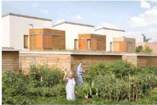
SENECHAL et DAUBER, architectes / Châlon sur Saône
