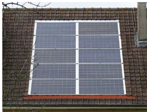
⊗ Interdit : les éléments de liaison ne sont pas de la même teinte que les panneaux. Source internet
