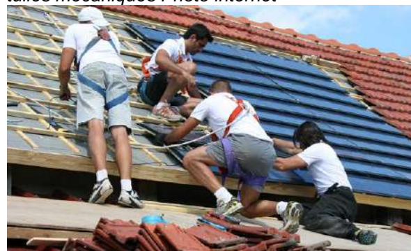
☺ Intégration de panneaux solaires sur une toiture en tuiles mécaniques. Photo internet SM
